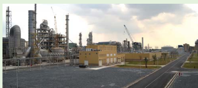
Một góc Nhà máy Đạm Cà Mau. Ảnh: Thái Sơn
